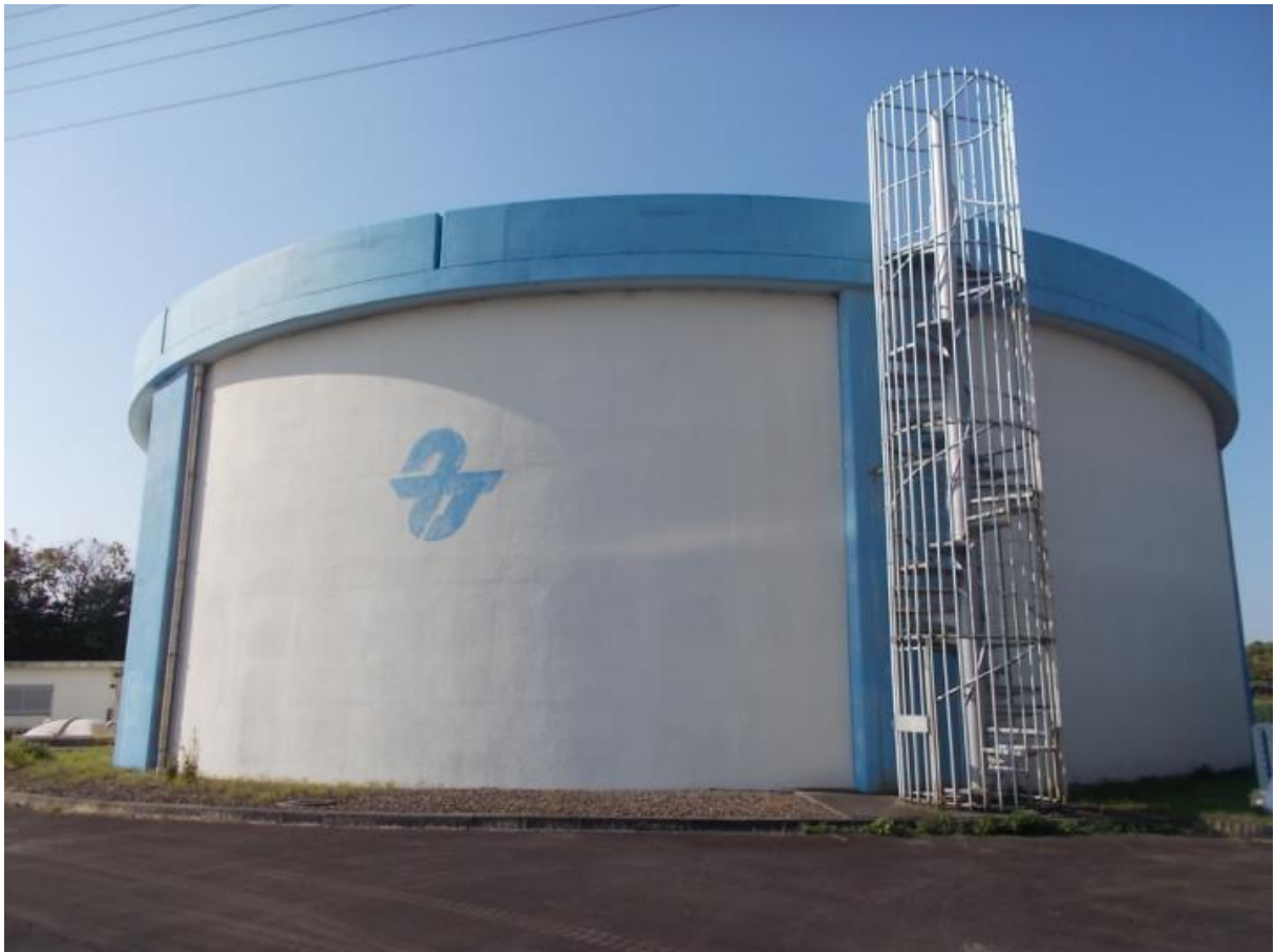
武豊第2配水池
